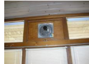
Sidewall propeller exhaust fan
