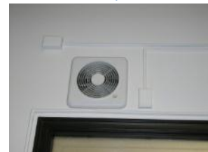
Transfer air wall propeller fan
