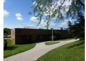
Site Light Pole
