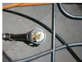
Pendant type sprinkler head
