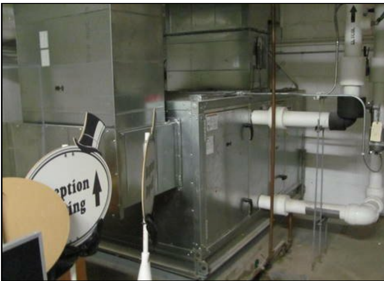
Bathroom exhaust fan
